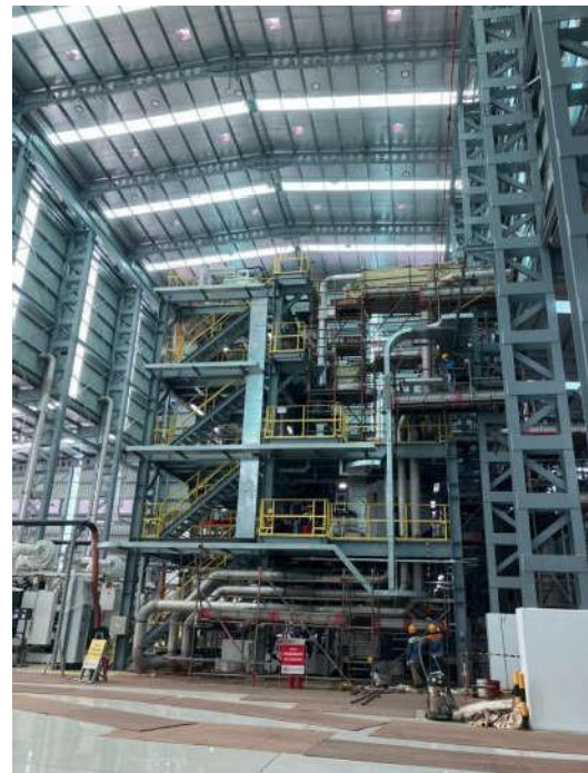
Gambar 2.6 Foto Lokasi Proyek
